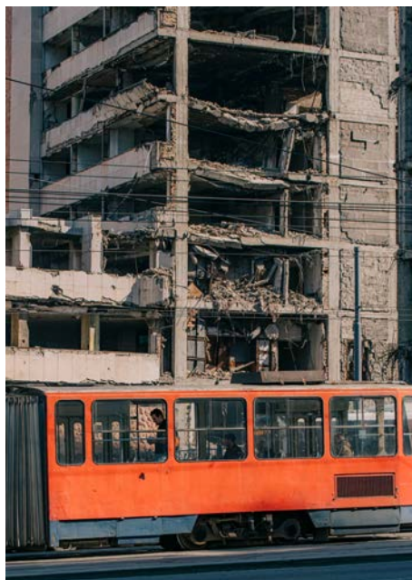
Ein 1999 durch die Nato zerstörtes Gebäude des Generalstabs der serbischen Armee, das von der Regierung bewusst als Ruine stehengelassen wird.
