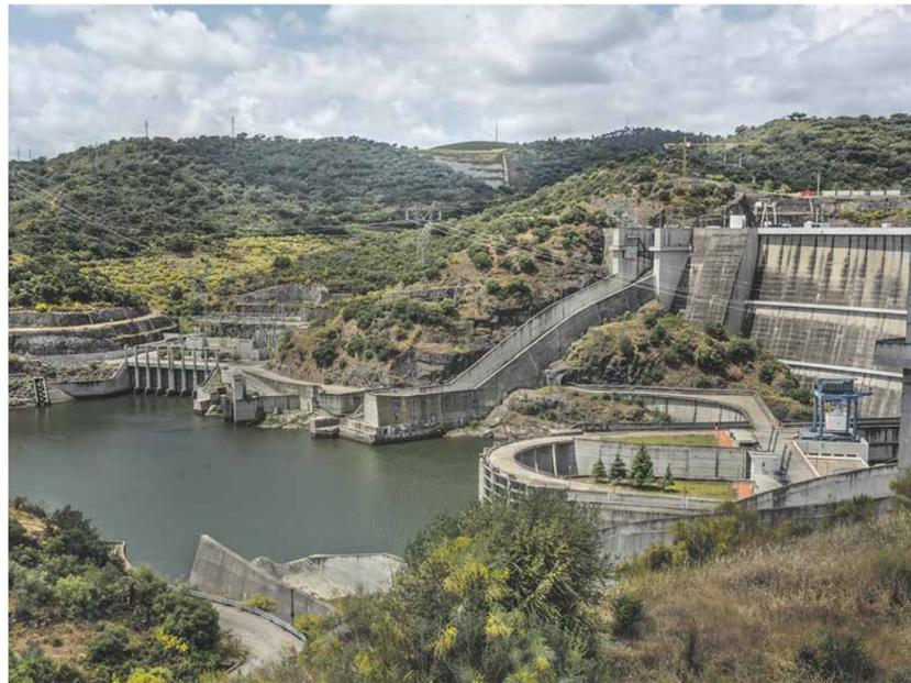
Die fast hundert Meter hohe Betonmauer des Alqueva-Staudamms
